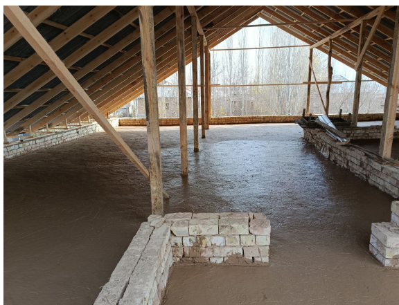
2-rasm. Yog'och to'sin va vassalarda yopilib loydan lo'mboz qilingan uyning ko'rinishi
