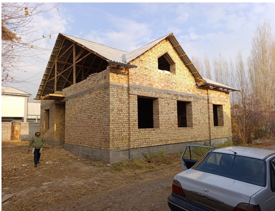
1-rasm. Pishgan g'ishtdan qurilib, tomi shiferda yopilgan hamda devorlari loy suvoq qilinadigan uyning umumiy ko'rinishi
